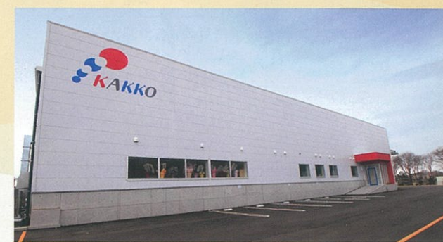
圏央道坂東ICより約2km、坂東インター工業団地内に位置する 角光化成 緑の里工場
